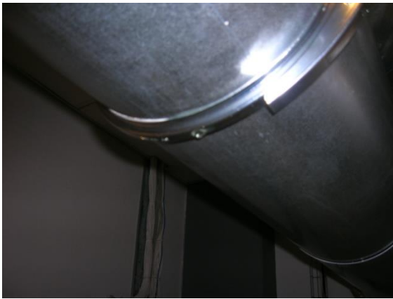
Bild 6. En droppe hänger under en otät skarv på kanalen.
