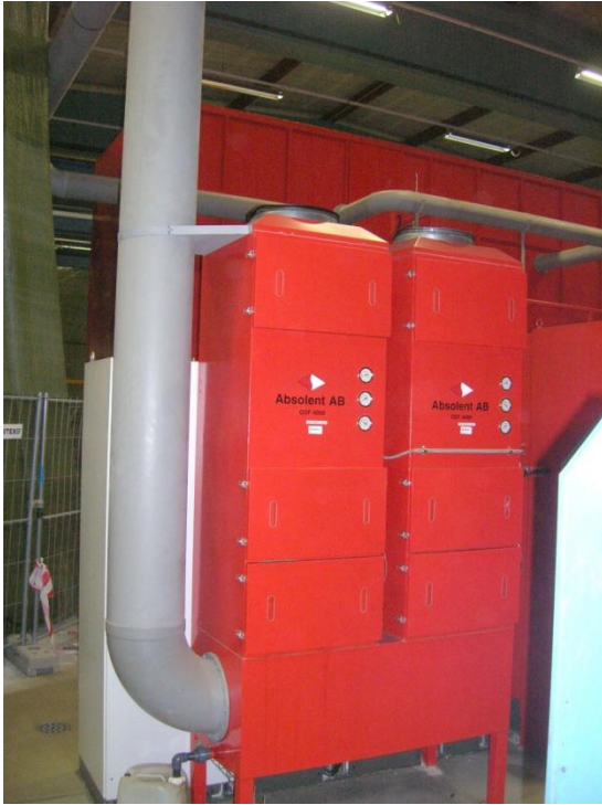
Bild 4. Absolentfilter med utblåset upptill och intaget nere till vänster. Ingen mätning utfördes på filtren som bilden visar.
