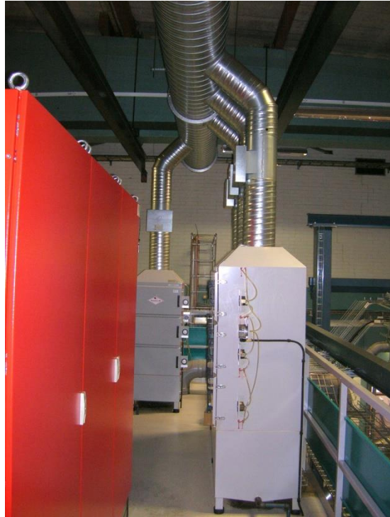
Bild 5. Rader med avskiljare (grå på bilden) med utblåsen anslutna till en frånluftskanal.
