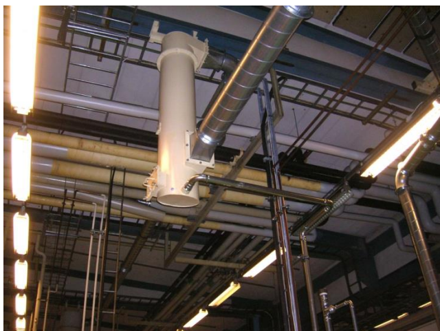
Bild 3. Exempel på avskiljning och dränering av skärvätska ur frånluften.
